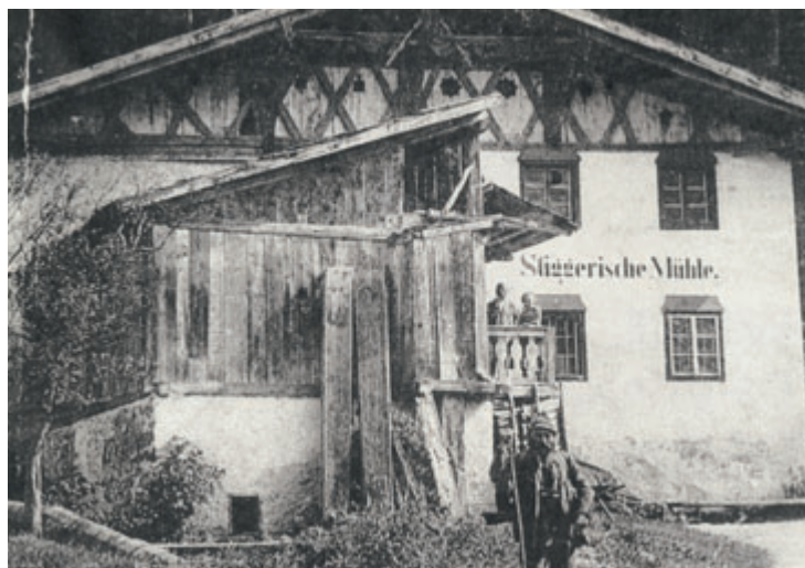
Außen und im Erdgeschoß wurde die historische Mühle (oben in früherem Zustand) bereits saniert und für die Zwecke des Krippenvereins adaptiert
